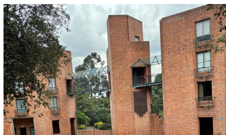
Imagen 02 Proyecto inmobiliario Nueva Santa Fe en el barrio Belén; fuente: los autores.
